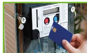
Il fonctionne par prépaiement via une carte électronique rechargeable. Il faut donc **charger sa carte avant d'avoir du gaz ou de l'électricité**.
